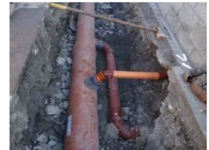
Einspitz als seitlicher Anschluss einer Transportleitung.
